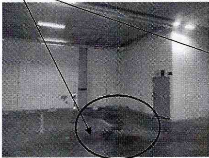
Fisuras en la placa túnel acceso peatonal
