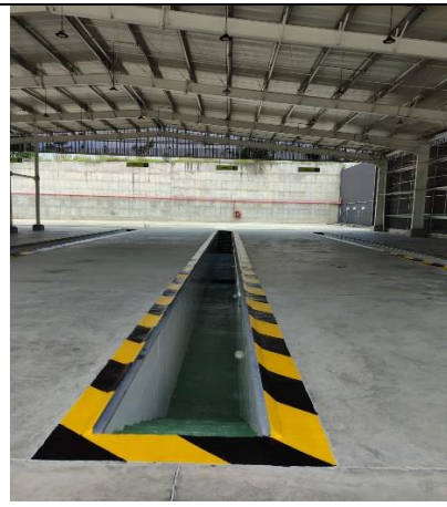
Adecuación Cárcamos de mantenimiento
