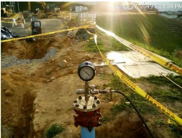
Obras de prueba hidrostática para red contra incendios
