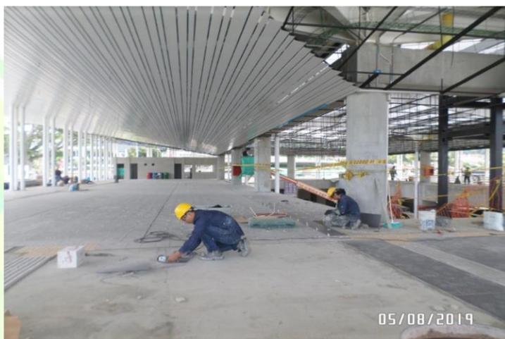
Las actividades que se llevaron a cabo fueron la continuación de la instalación de las correas y las láminas del cielo raso y el frontón, así como también la perforación de los puntos donde se instalaron las luces LED, se continuo con la instalación del piso NBK y se inició el sellado de la
