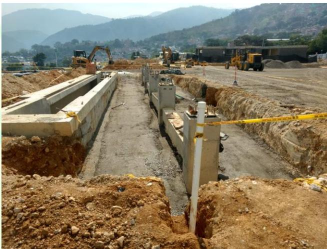
Obras de excavación y replanteo cárcamo lavado
