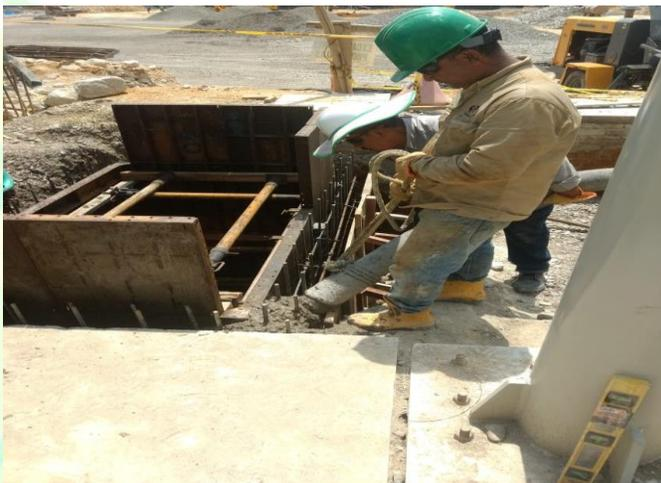
Obras de vaciado concreto caja residuos líquidos en el Edificio de mantenimiento
