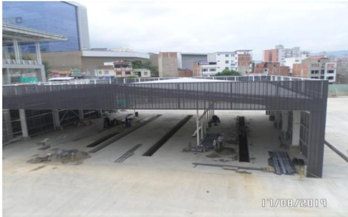
Se desarrollaron actividades como la terminación de la instalación del miniwave sobre la fachada de cárcamos, así como también se le realizaron los nichos a cada cárcamo, en la parte alterna a taller se realizó la instalación del cableado con sus respectivos puntos eléctricos, para proseguir con la instalación del cielo raso y así se finalizó con la aplicación del estuco sobre los muros.
