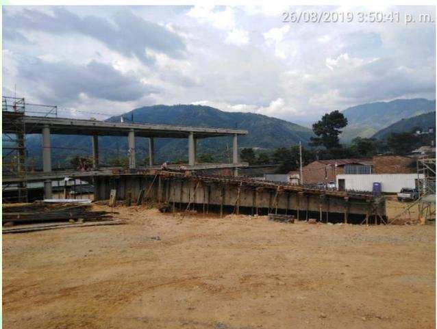
Obras de encofrado para el voladizo del muro T4 en el Edificio de acceso a la Estación de transferencia
