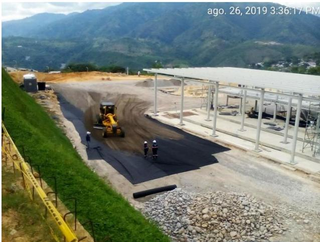
Obras de extendido de la sub base para el pavimento MR en el Patio Taller
