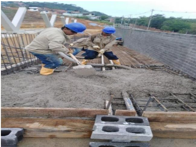
Obras de vaciado del concreto para rampa norte de acceso a plataformas de embarque Estación de Transferencia
