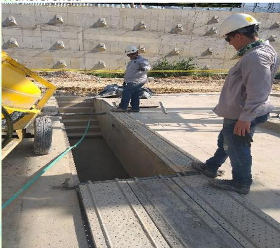
Obras de cubrimiento de los cárcamos en el Edificio de mantenimiento del Patio Taller
