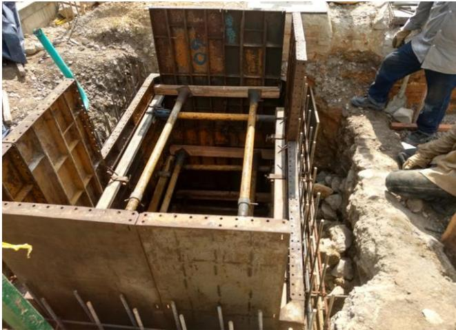
Obras de encofrado caja residuos líquidos en el Edificio de mantenimiento
