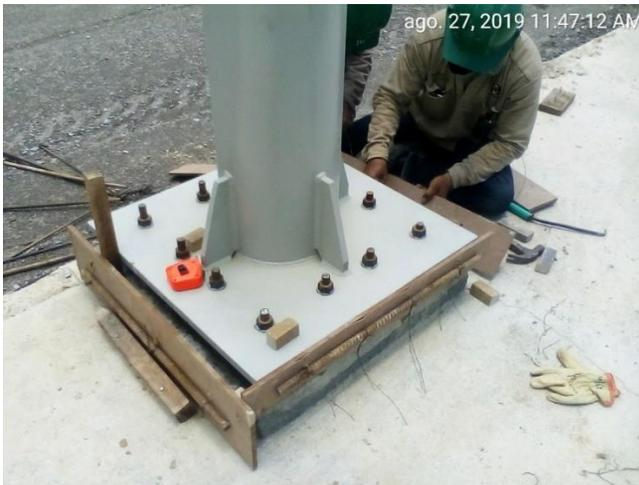
Obras de encofrado grouting de nivelación columnas metálicas en el Edificio de mantenimiento
