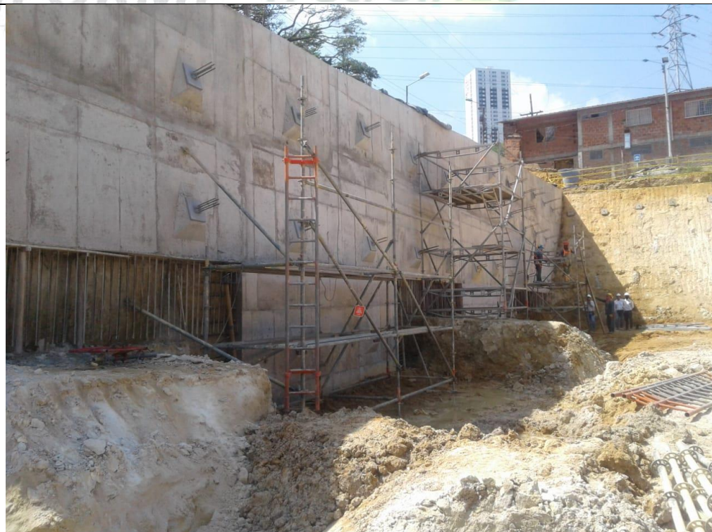
CONSTRUCCION DE MURO PANTALLA ANCLADA EN PATIO TALLER
