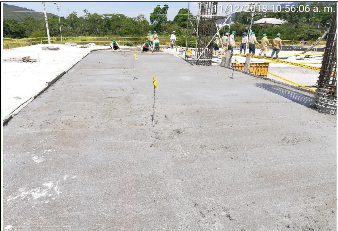
FUNDICION DE PLACA EN CONCRETO DE 4000 PSI EN ZONA DE TRANSFERENCIA
