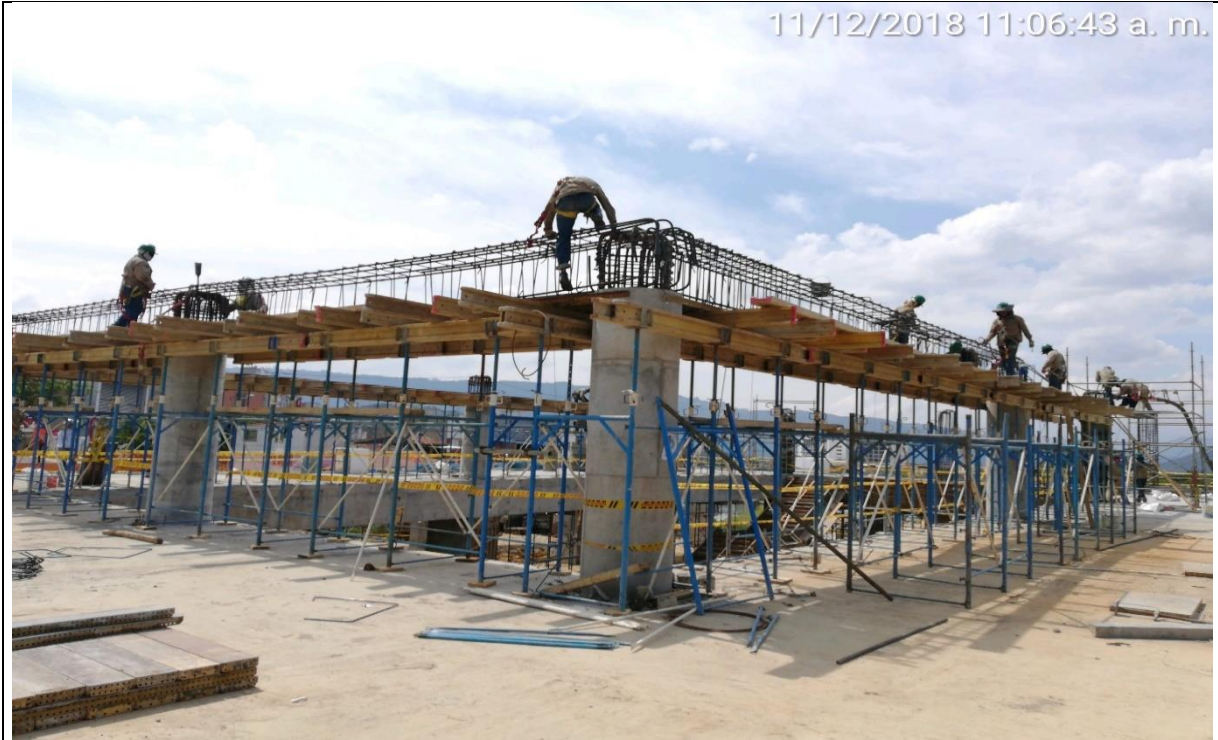
MONTAJE DE VIGAS ESTRUCTURALES EN ZONA DE TRANSFERENCIA
